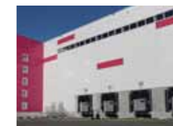
Распределительный центр Wildberries г. о. Подольск, МО
